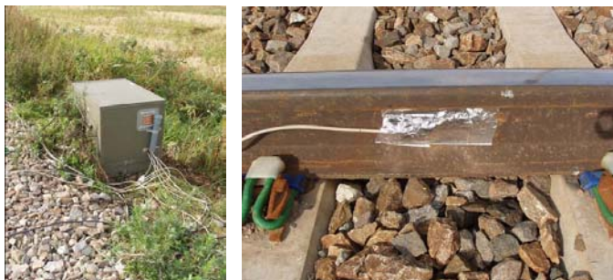
Figur 3. Mätskåp och trådtöjningsgivare på räl för mätning av rälsspänning för kontroll av befästningsklämkraftens inverkan.
