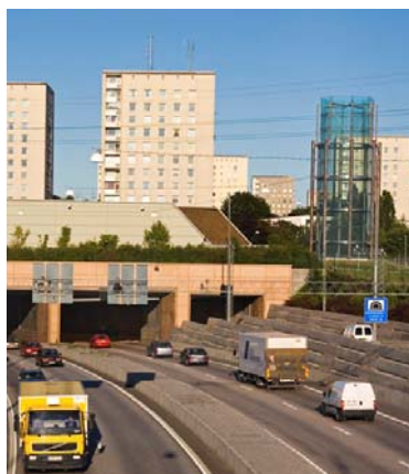
Befintligt frånluftstorn Södra länken
