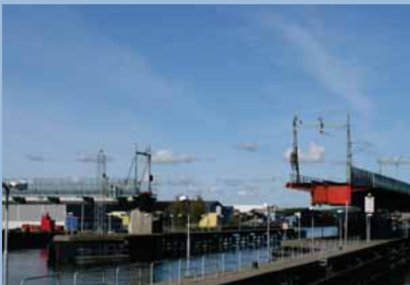
Befintlig Marieholmsbro i öppnat läge.
