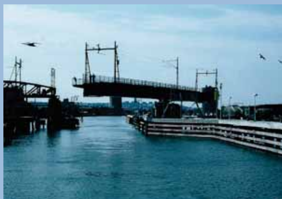
Lyftsvängbron vid Mariefors vid montage 1996.
