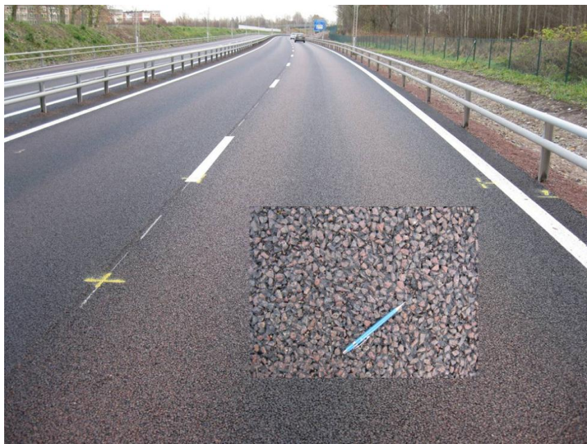
Nylagd gummi-asfaltbeläggning, GAÖ 11, på Söderleden i Norrköping
