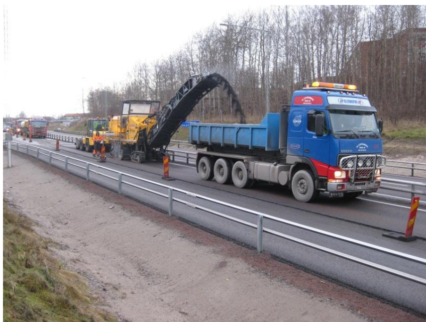
Fräsning av beläggningen på Söderleden (ca 1 månad efter utläggning).
