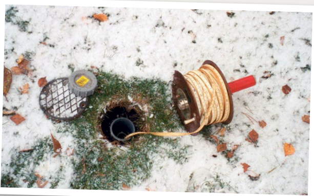
I dagsläget ingår totalt 842 mätpunkter i Västlänkens kontrollprogram för grundvatten. Upptäcker vi en avvikelse under byggtiden kan en första åtgärd vara att mäta oftare. FOTO: VÄSTLÄNKEN
