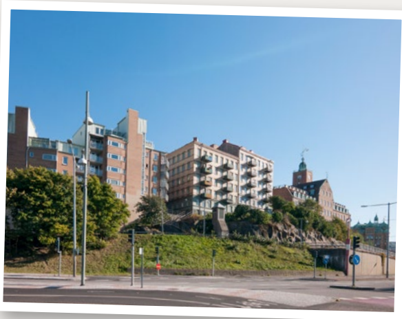
Inför och under bygget av Västlänken samlar vi in kunskap om mark och byggnader, mäter och följer upp vårt arbete.
