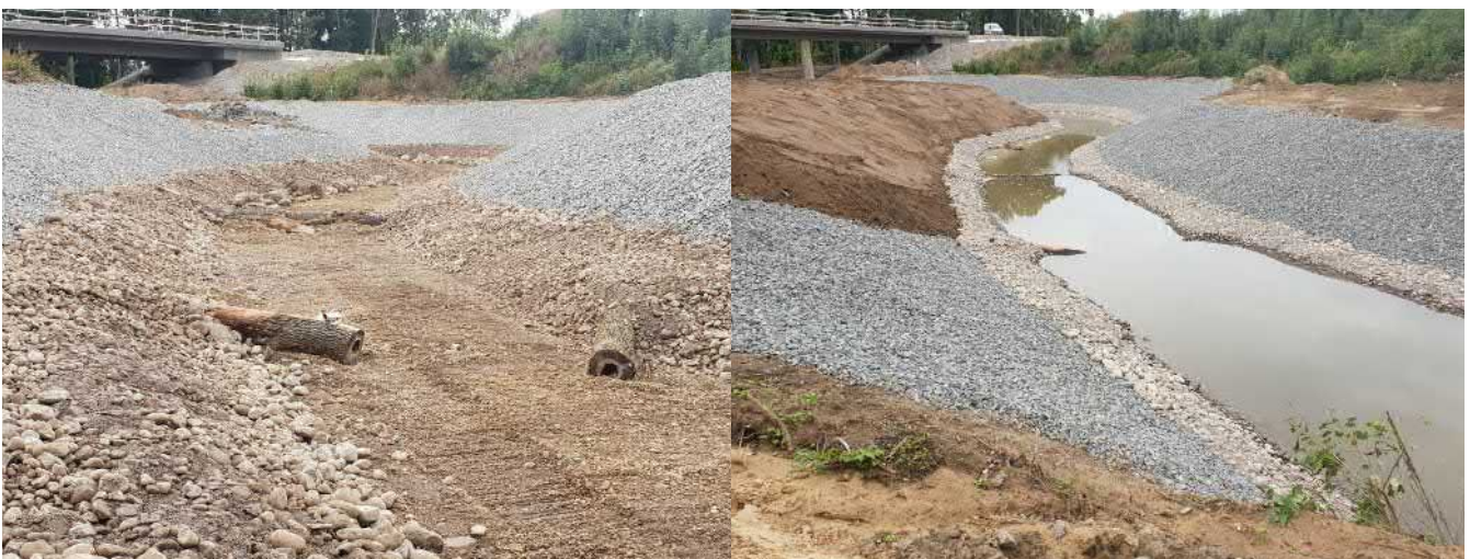
Öredalsåns nya läge före och efter att vattnet släppts på.
