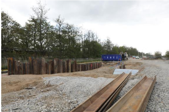
Spont (stödvägg) nordöst om Åkarps station
