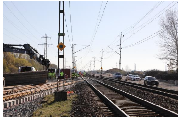
Rälisen till de tillfälliga spåren kommer börja byggas från området söder om E6 broarna
