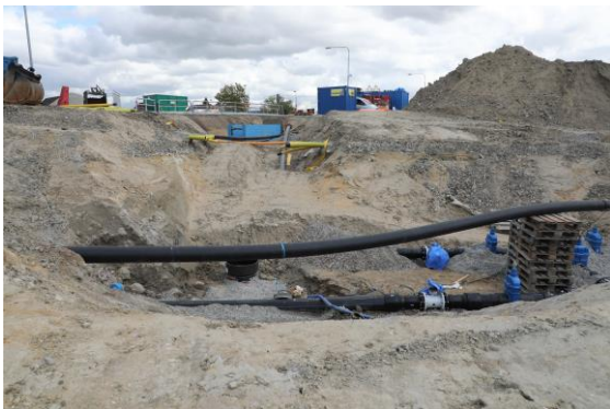
Ny dricksvattenledning samt el- och telekablar vid Sockervägen.
