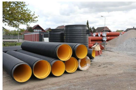
Rör till spillvattenledningar
