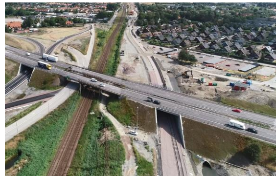
Drönbild över trafikplats Alnarp och Sockervägen från 2 augusti
