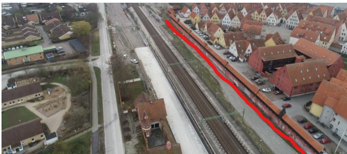
Här ska spontväggen byggas. Bild: NCC/OHL.
