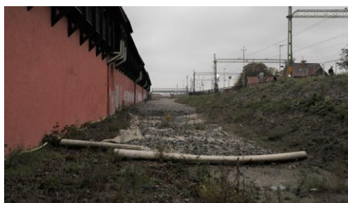
Muren mellan Jakriborg och stationen där spontväggen ska byggas. Bild: NCC/OHL.
