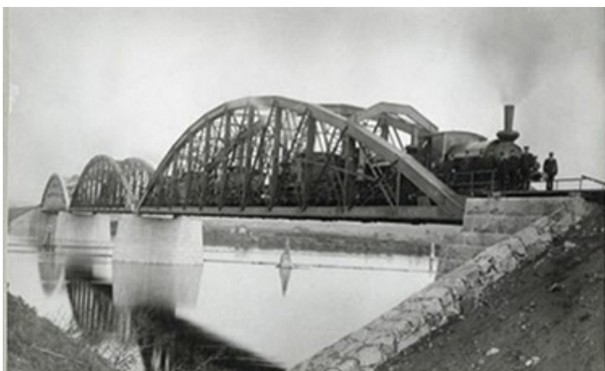
Figur 2. Den gamla järnvägsbron, en bågformad bro i tre segment byggd år 1896, placerad på fyra brostöd varav två i Vindelälven.
