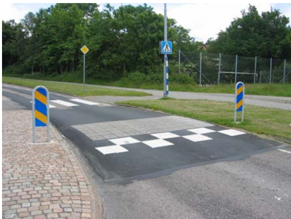
Diagram 27 och 28. Gupp placerat framför övergångsstället i båda körriktningar. Bred refug har kompletterat övergångsstället.
