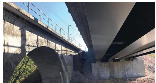
Under denna vecka rivs även den gamla järnvägsbron över Stångån. Broarna knackas ned med en hydraulhammare vilket kan upplevas bullerstörande. Rivningen startar tisdag 30 juni k. 07.00 och beräknas vara klart söndag 5 juli kl. 17.00.
