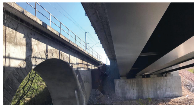
Under denna vecka rivs även den gamla järnvägsbron över Stångån. Broarna knackas ned med en hydraulhammare vilket kan upplevas bullerstörande. Rivningen startar tisdag 30 juni kl. 07.00 och beräknas vara klart söndag 5 juli kl. 17.00.
