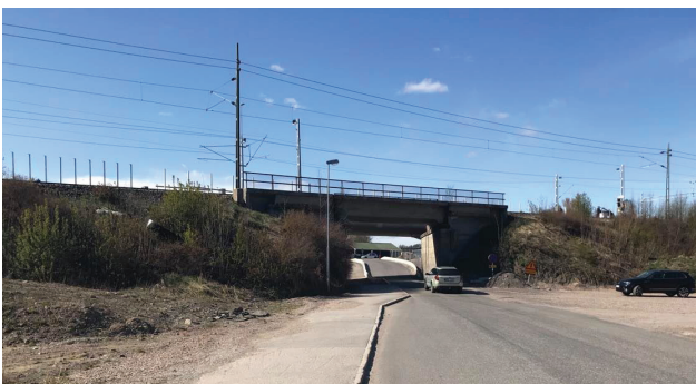
Den gamla järnvägsbron över Mjösundsvägen ska rivas, det innebär att vägen hålls stängd för genomfart 29 juni kl 9.00 till midnatt den 5 juli. Biltrafiken leds om. Gående och cyklister kan passera via en provisorisk tunnel från tisdag morgon.
