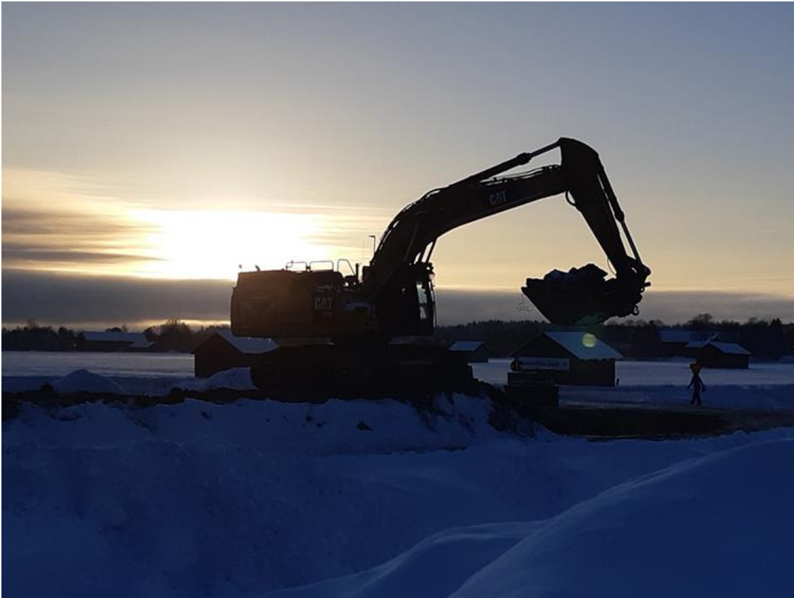
Utlastning av asfalt vid blivande Böleängsrondellen.
