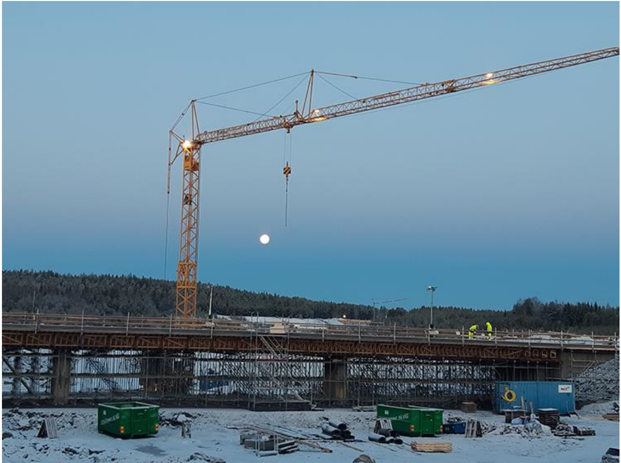
Bro 542 vid pågående rivning av formställning.
