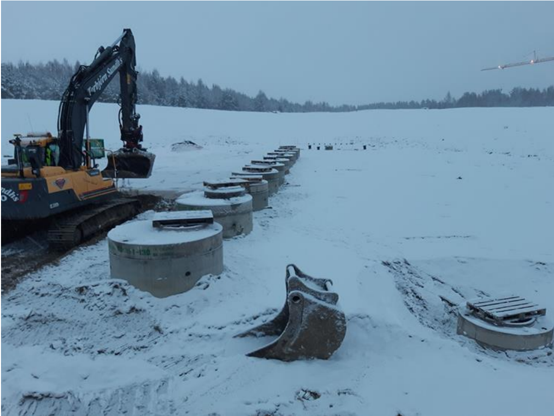
Infiltrationsanläggningen i Grop 42.
