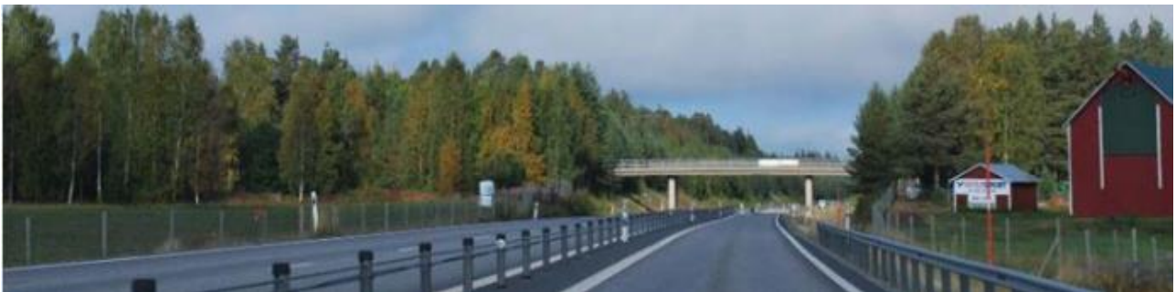
Tingsholmsbron, foto: Trafikverket
