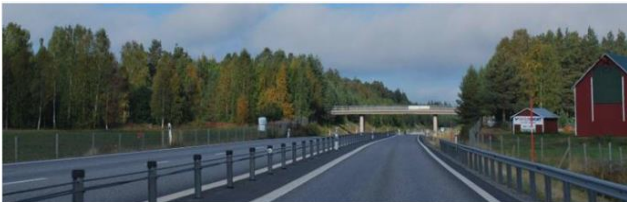
Tingsholmsbron. Foto: Trafikverket
