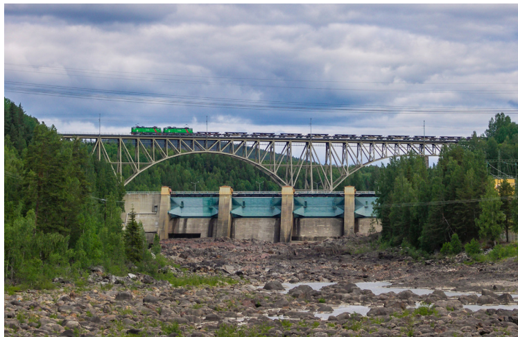
Forsmobron och Forsmo vattenkraftverk. Foto: David Larsson
