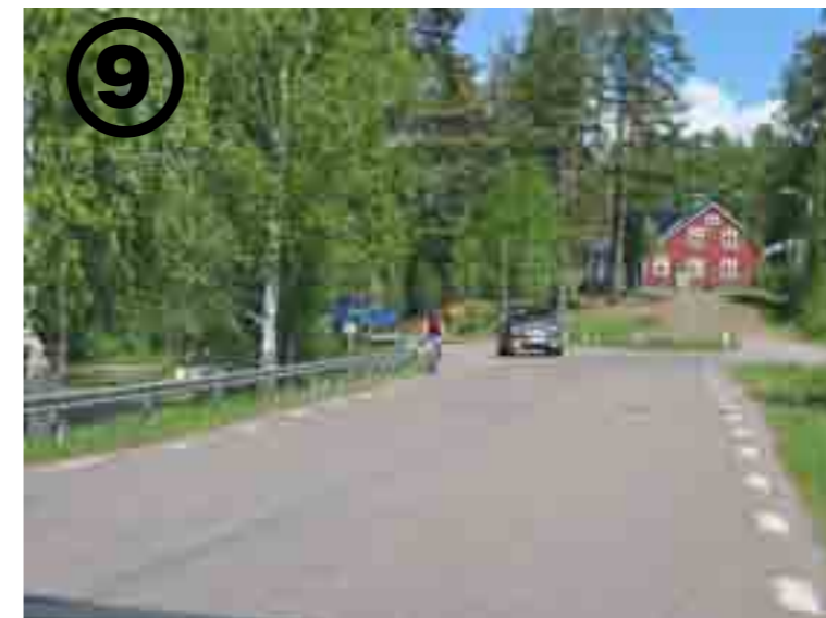
Stjärnsund - Tillfart från öster. Ev. vägmidja som entré. Förslag på utformning enligt bild A.
