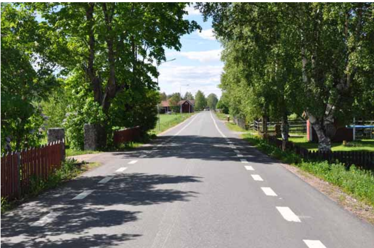
Figur 3.3 Exempel på utformning av Bymiljöväg längs väg 590 genom Östtjärna, Gagnefs kommun, Dalarna.
