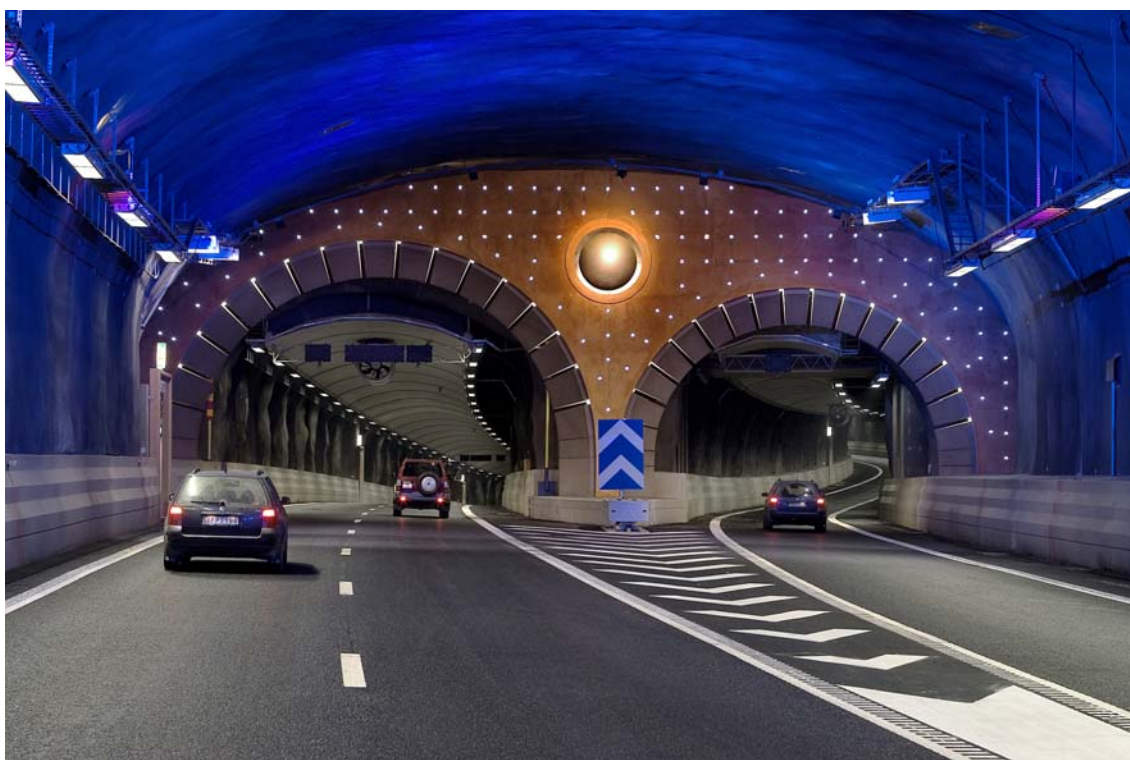
Figur 3 Bild från tunneln i Södra länken. Här visas en huvudväg med avfartsväg. Huvudvägen blir dock trefilig i Förbifart Stockholm. I övrigt är konstruktionerna ganska lika. Foto från Vägverket, Mikael Ullén.
