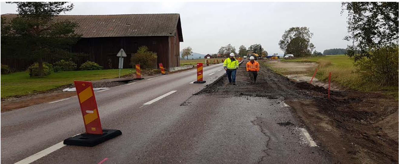
Inspektion pågår av överbyggnaden vid utfarten till Sellnäs..
