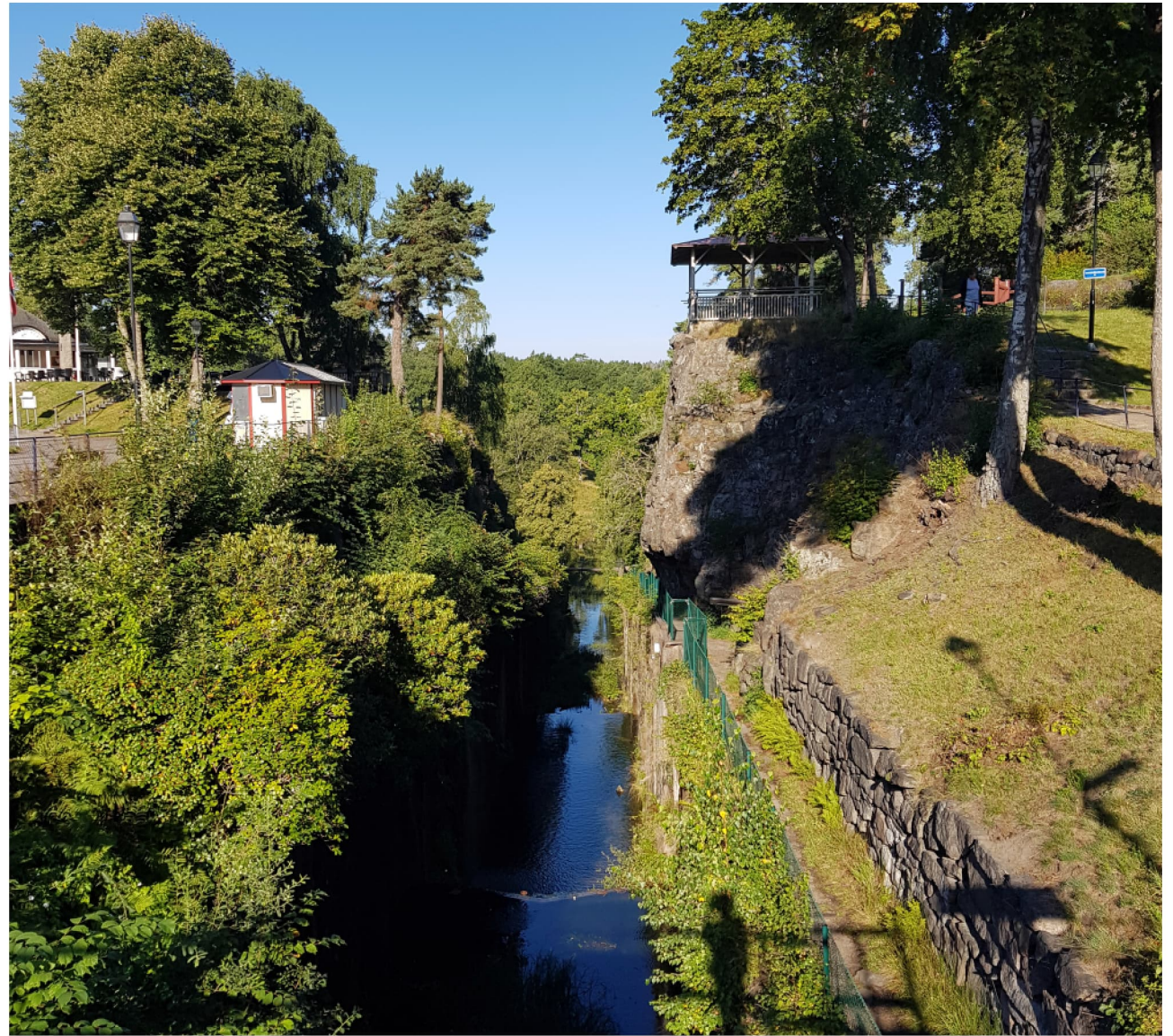
Figur 171 1800 års sluss. Till höger skymtar en utkikspunkt under tak.
