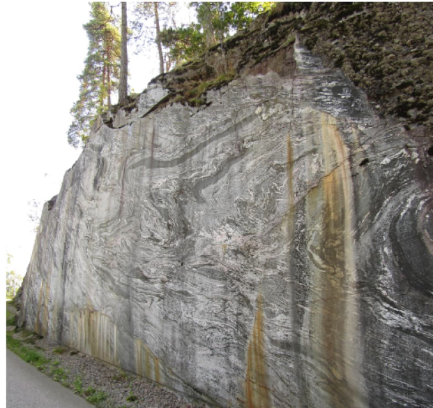
Figur 109 Bergsskärning söder om sluss 3-6 från 1916.
