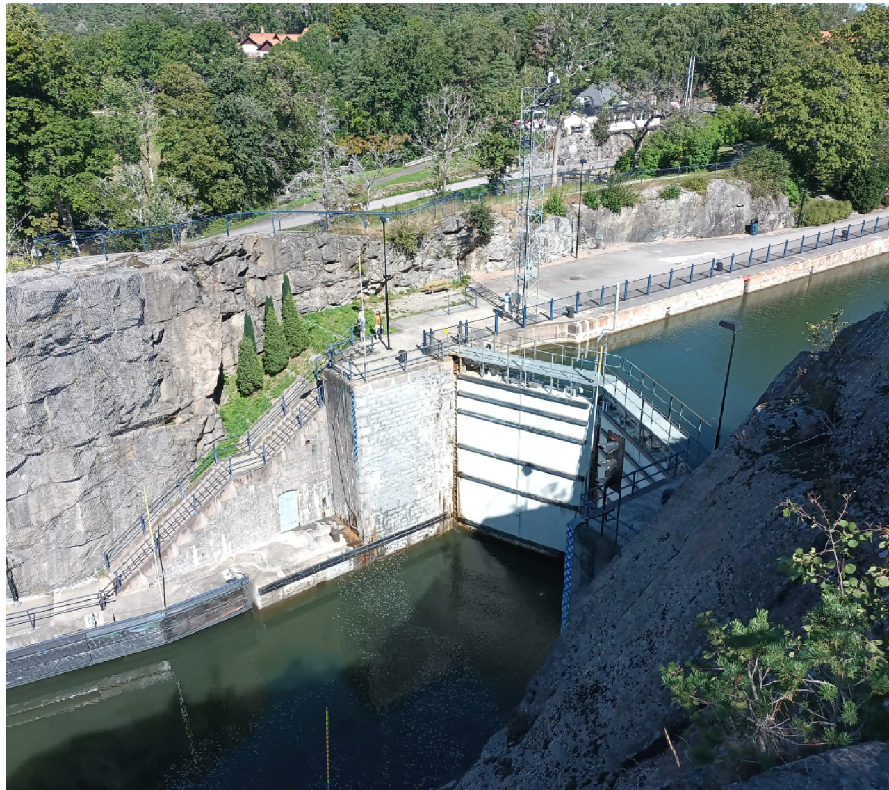
Figur 178 Slussen i Trollhättan omges av höga bergsskärningar.
