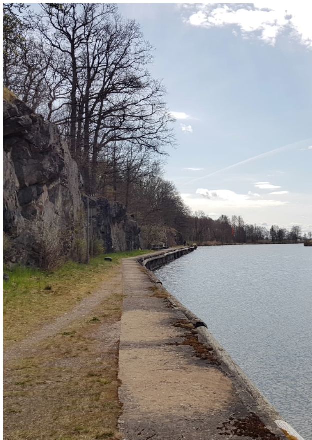
Figur 83 Nedströms slussen. Till vänster syns de bergsskärningar som gjordes när slussen byggdes 1916. Vägen är den gamla dragvägen, som murades 1916 och användes för att dra båtar längs med land.
