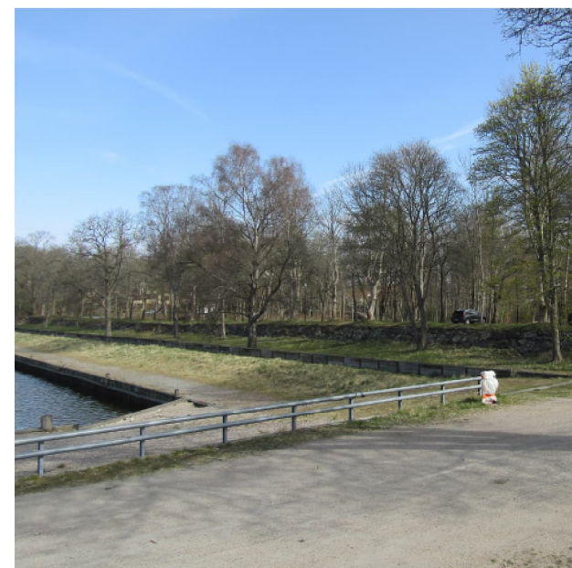
Figur 65 Befintlig dammvall nordöst om slussen.
