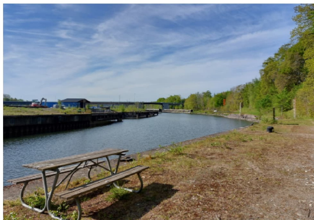
Figur 235 Nedströms slussen, södra strandzonen. Till vänster i bild syns Inlandsön.
