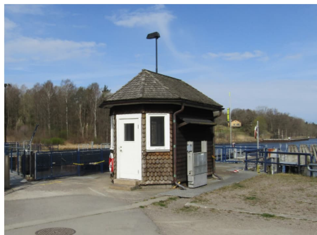
Figur 8 Spånbeklädd manöverhytt av denna modell återfinns i alla tre slussområdena.
