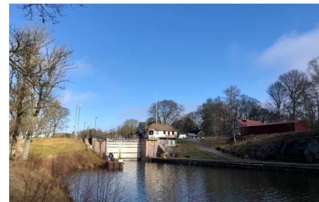
Figur 1 Sluss med stängda slussportar i Vänersborg. Byggnaden till höger om slussen i bild är manöverhytten.
