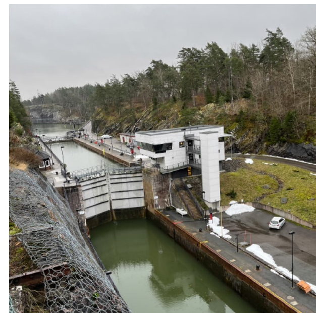
Figur 161 Utsikt över befintlig sluss från en skogsstig belägen norr om slussen.
