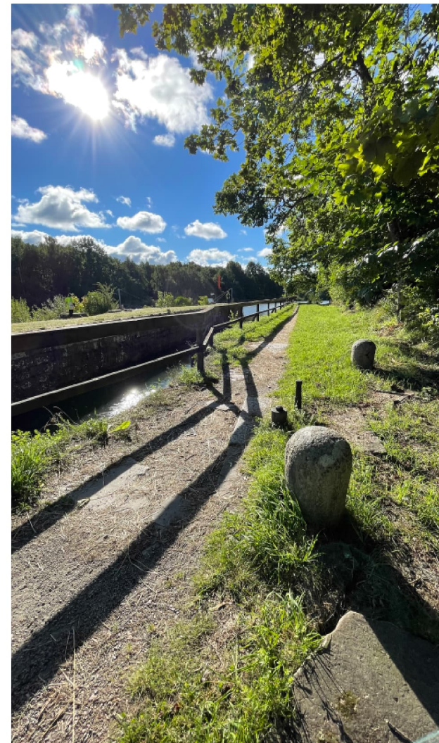
Figur 52 1844-års sluss ("Bommens sluss") med stenpollare som användes vid angöring. Bommens sluss kanal ingår i karaktärsområde 3.
