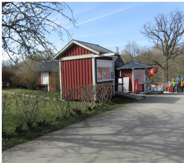
Figur 59 Glasskiosk belägen vid befintlig sluss.
