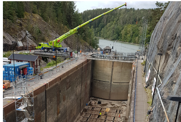
Figur 5 Tömd sluss i Trollhättan.
