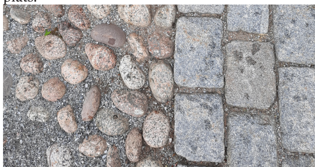
Figur 52 Bildexempel på återbrukat stenmaterial.
