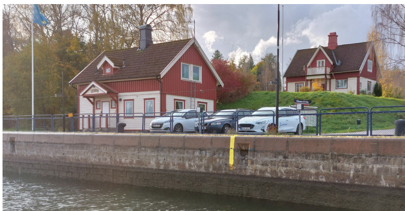
Figur 57 Byggnadernas placeringar berättar om deras ursprungliga funktioner och är en viktig aspekt vid val av nya placeringar. På fotot syns kanalkontoret och slussvaktarbostaden vid Ströms sluss, Lilla Edet.
