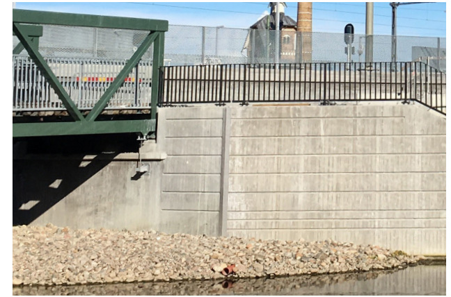
Figur 68 Betongmur gjuten med trälister i formen.
