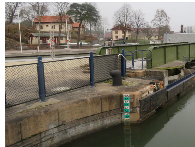
Figur 31 1916 års slussar och kanaler kantas i stora delar av miljön av stenkajer där blocken huggits individuellt i mjukt rundade former.
