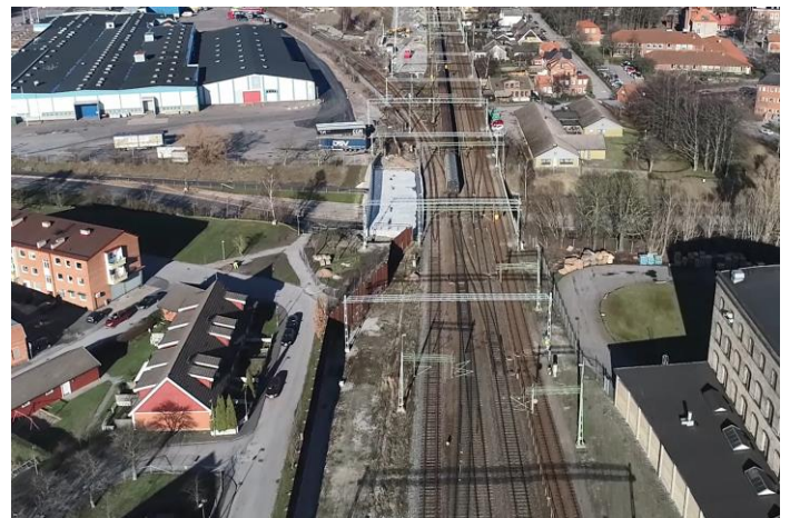
Bullerskyddet vid Järnvägsbron över Lommavägen i Arlöv förbättras.
