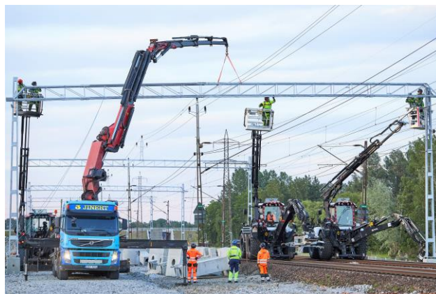
Montering av kontaktledningsbryggor. Bild: NRC Group
