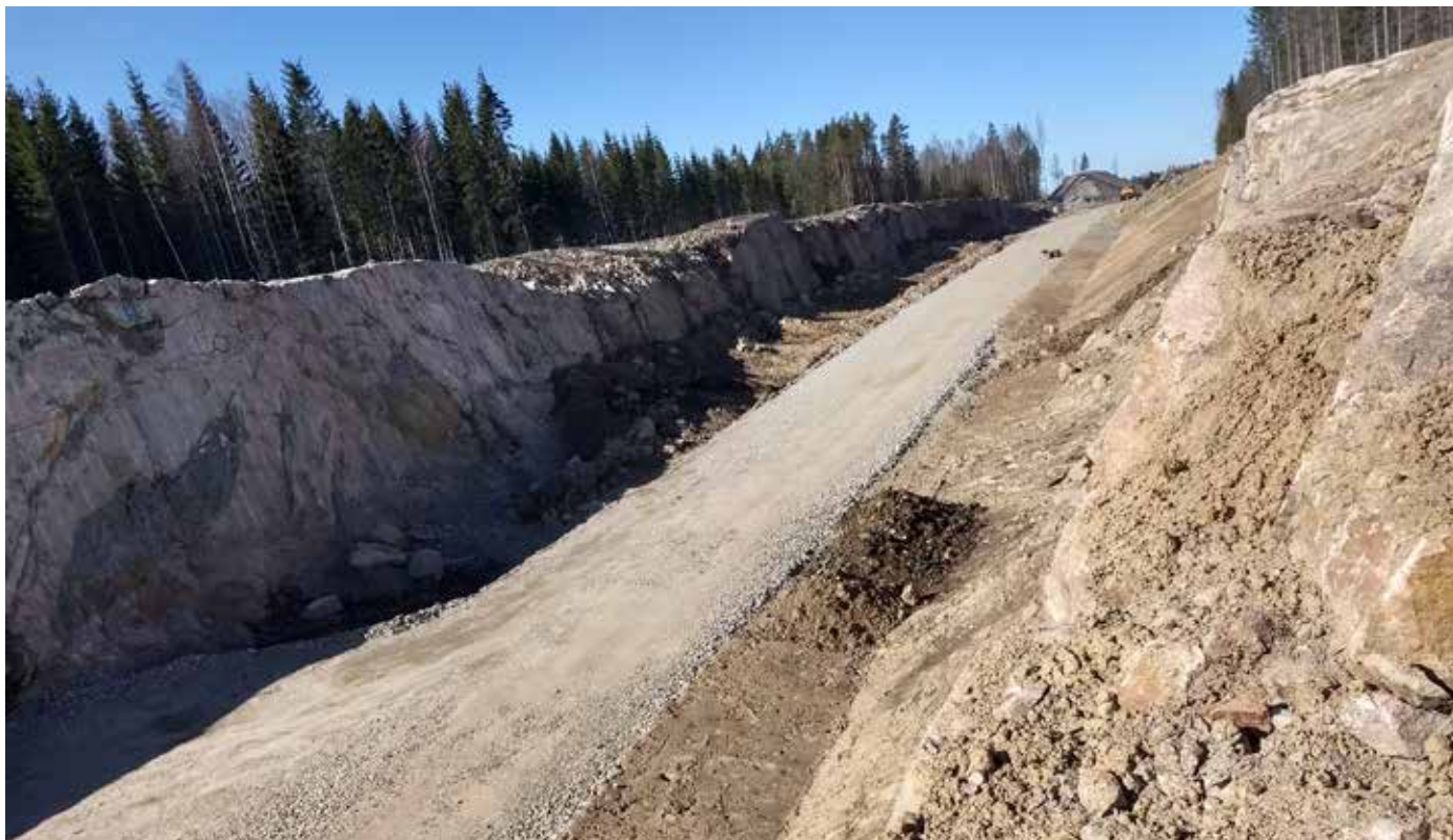
Nya riksväg 51 växer fram i landskapet, söder om Pålshoda.
