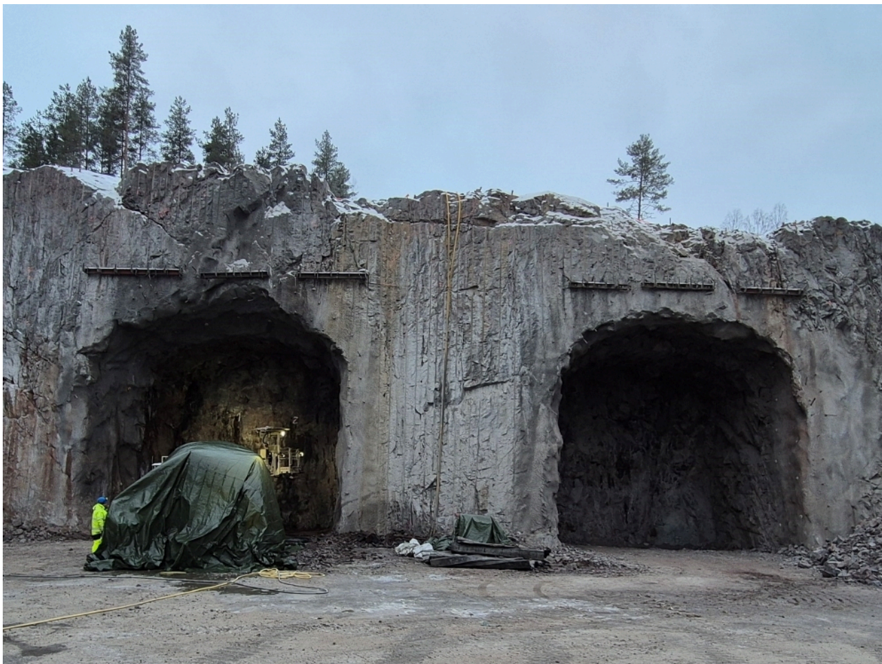
Tripphultstunnelns södra tunnelmynning i februari 2026. Foto: Carlos Perez Rioja.
