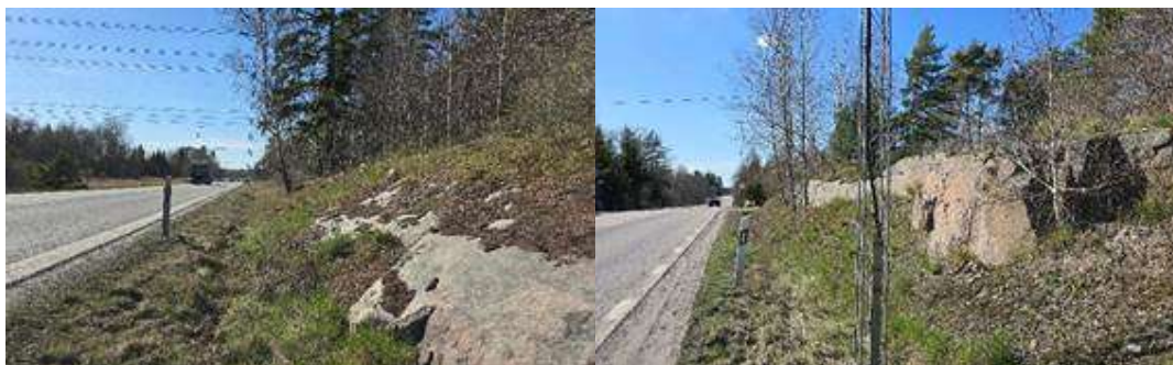
Figur 47. Exempel på befintliga bergskärningar längs sträckan.
