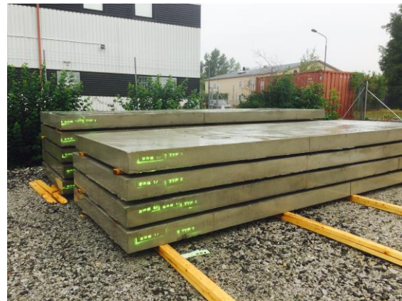
De gjutna betongplattorna som ska transporteras till E6 broarna
