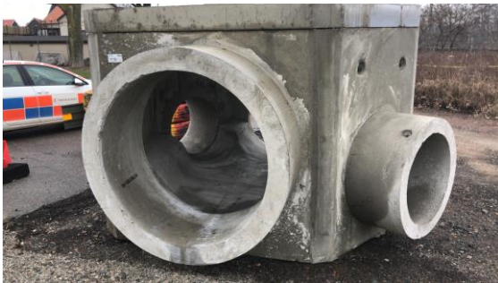
Brunnen är en så kallad anslutningsbrunn. Den samlar flera ledningar från olika håll.
