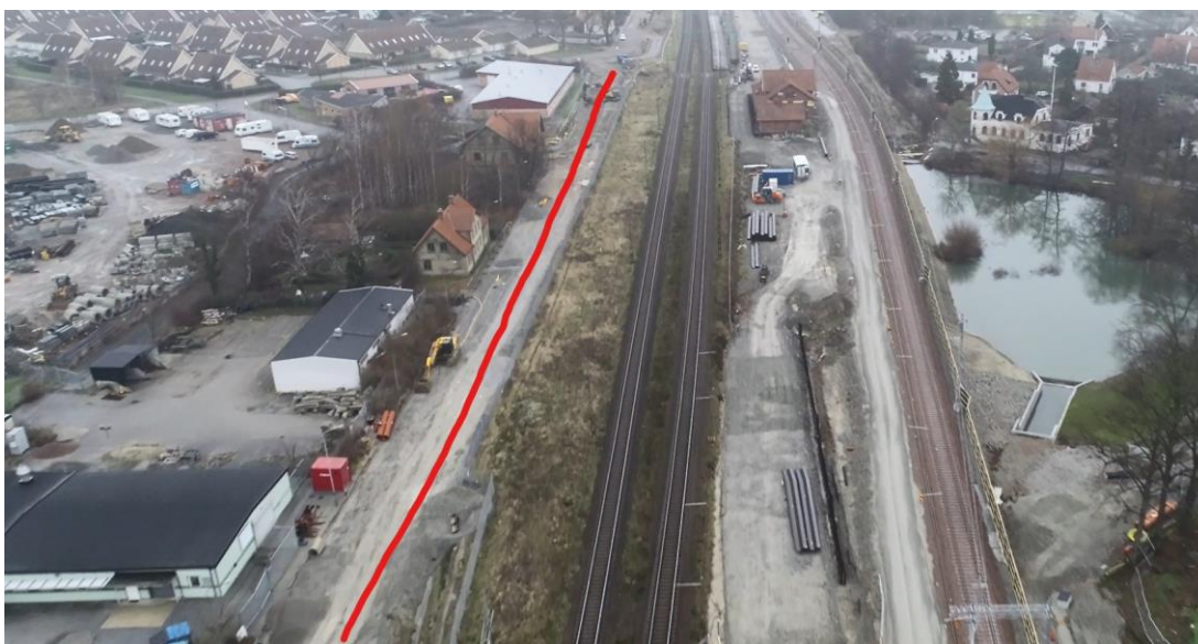
Stödväggen av stål ska byggas mellan Bruksvägen och de befintliga spåren. Bild: NCC/OHL.
