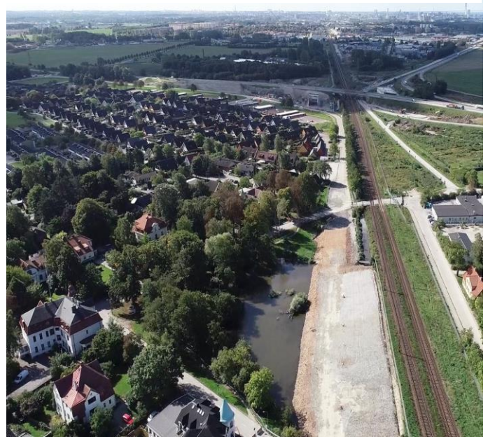
Arbeten vid Åkarpsdammen och på Sockervägen
