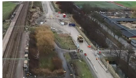
Området öster om Åkarps station där de tillfälliga spåren ska byggas
