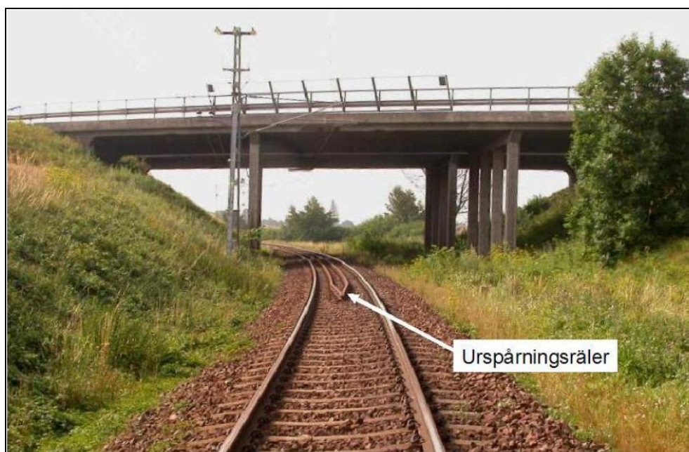
Figur 2.3. Urspårningsräler vid viadukt.
