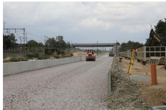
Spårbädd norr om Åkarps station
