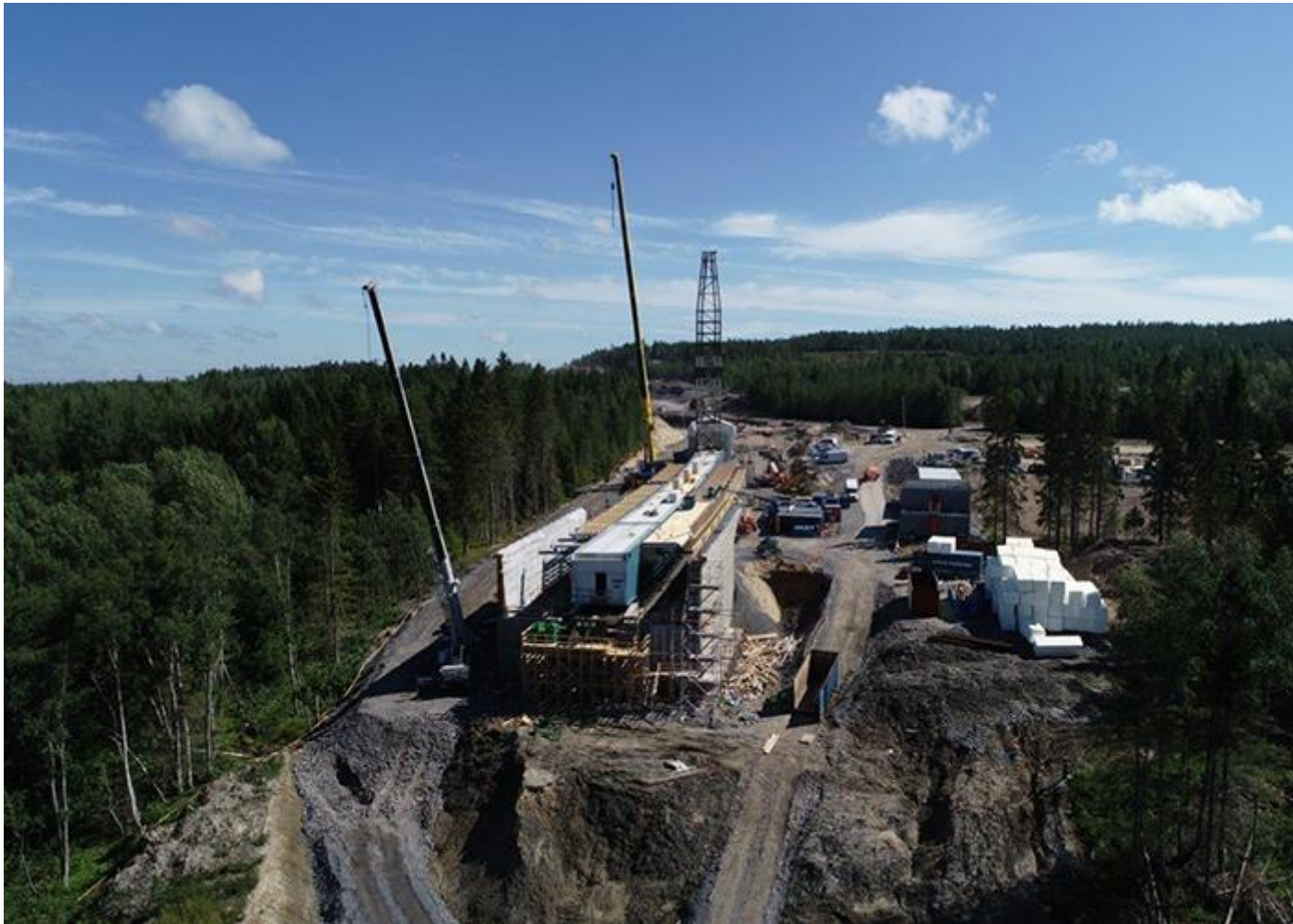
Brolanseringsplanen mot söder, i bild syns bland annat arbetet med att bygga formställning för broöverbyggnaden som ska gutas. Foto: Jan Öberg
